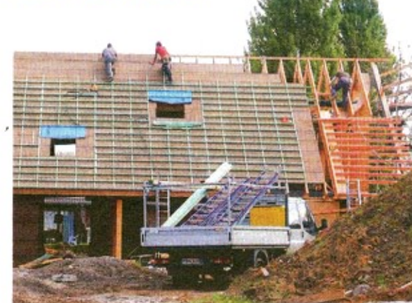
Il y a 35 cm d'isolant sous la toiture.
